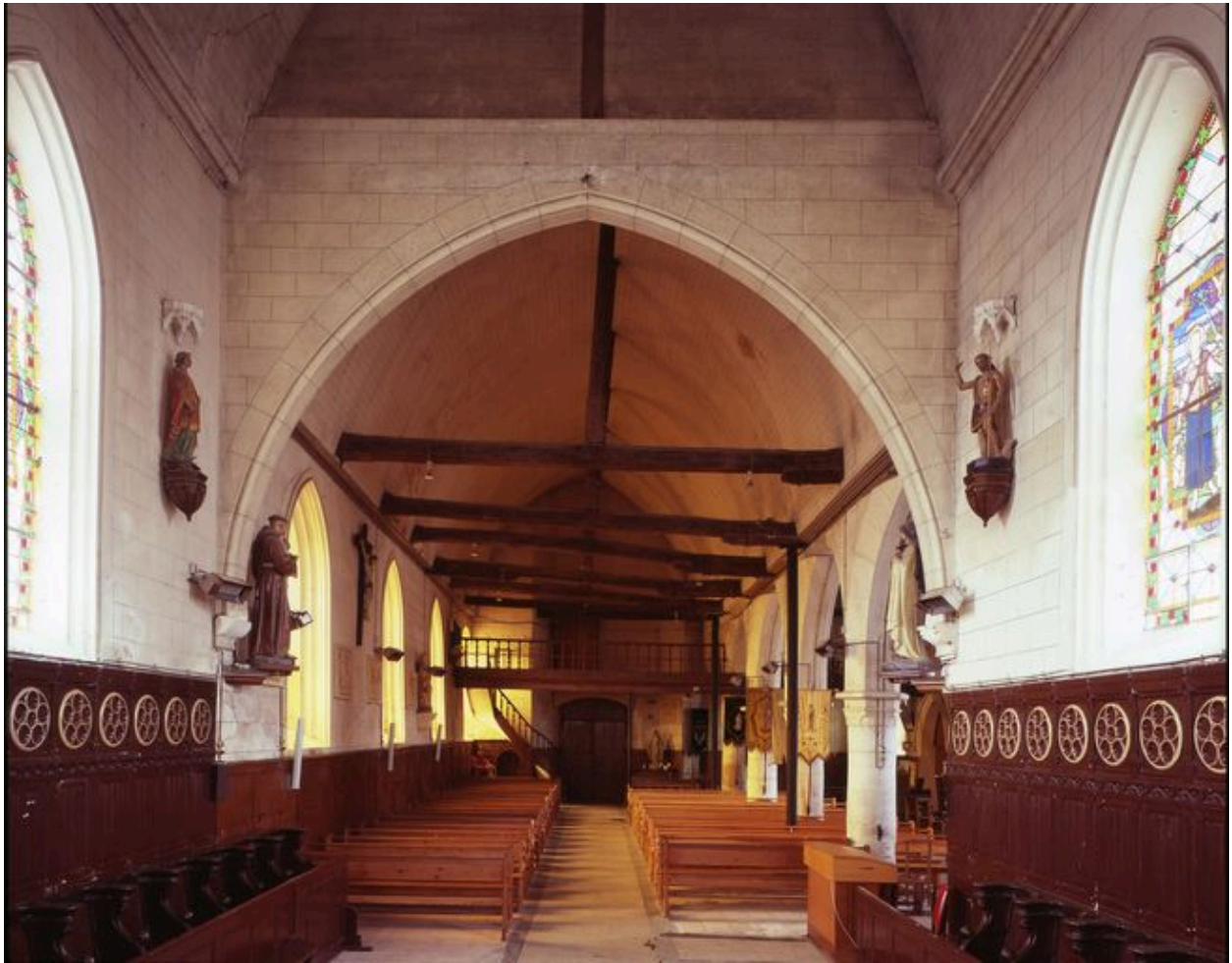
Vue intérieure de la nef.
