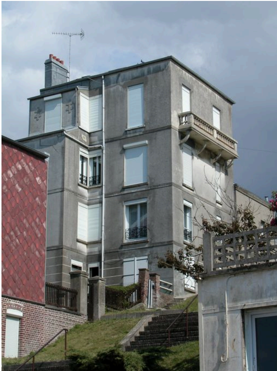
Vue depuis la rue de Saint-Valery, façade sur mer.
