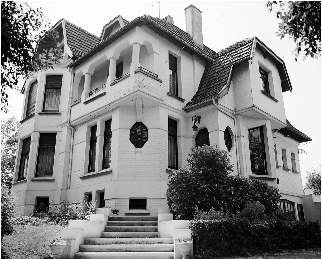
Vue de trois-quarts de l'élévation.
