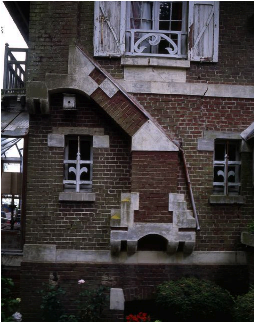
Détail de la fausse cheminée décorative en façade antérieure.
