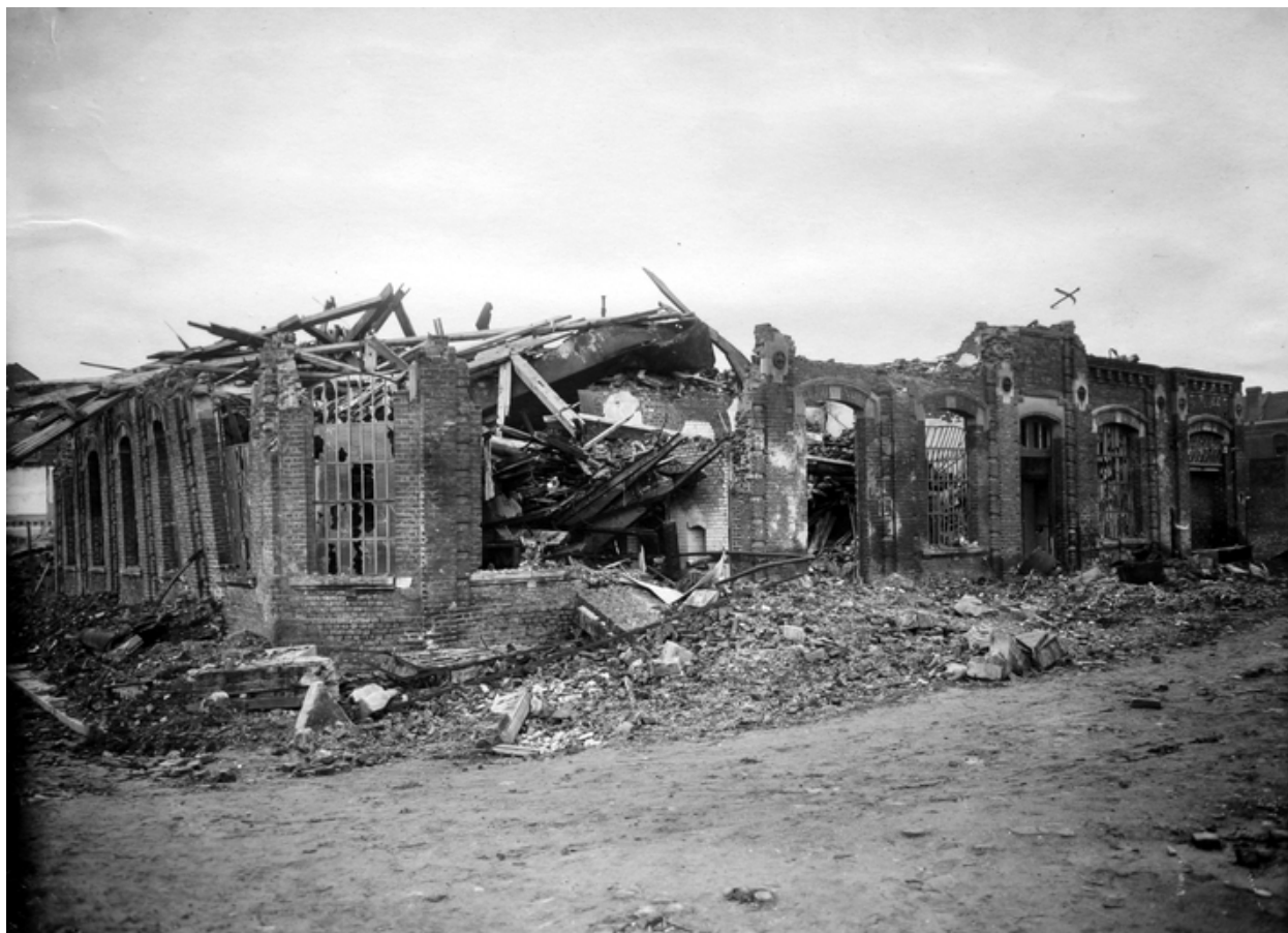
Les ruines de l'usine photographiées en 1919 (AD Aisne).
