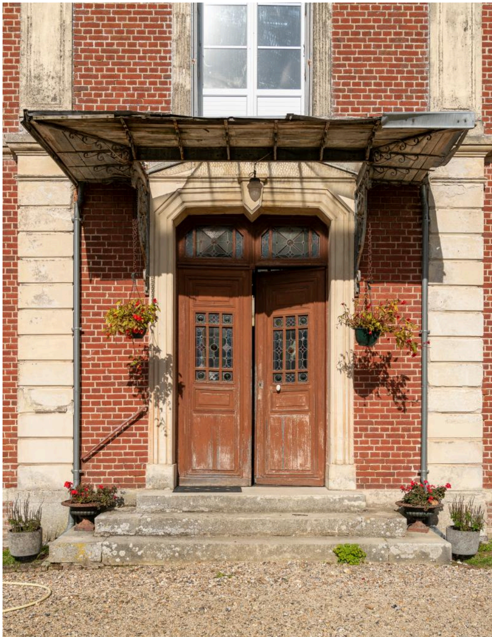
Entrée du logis côté sud.
