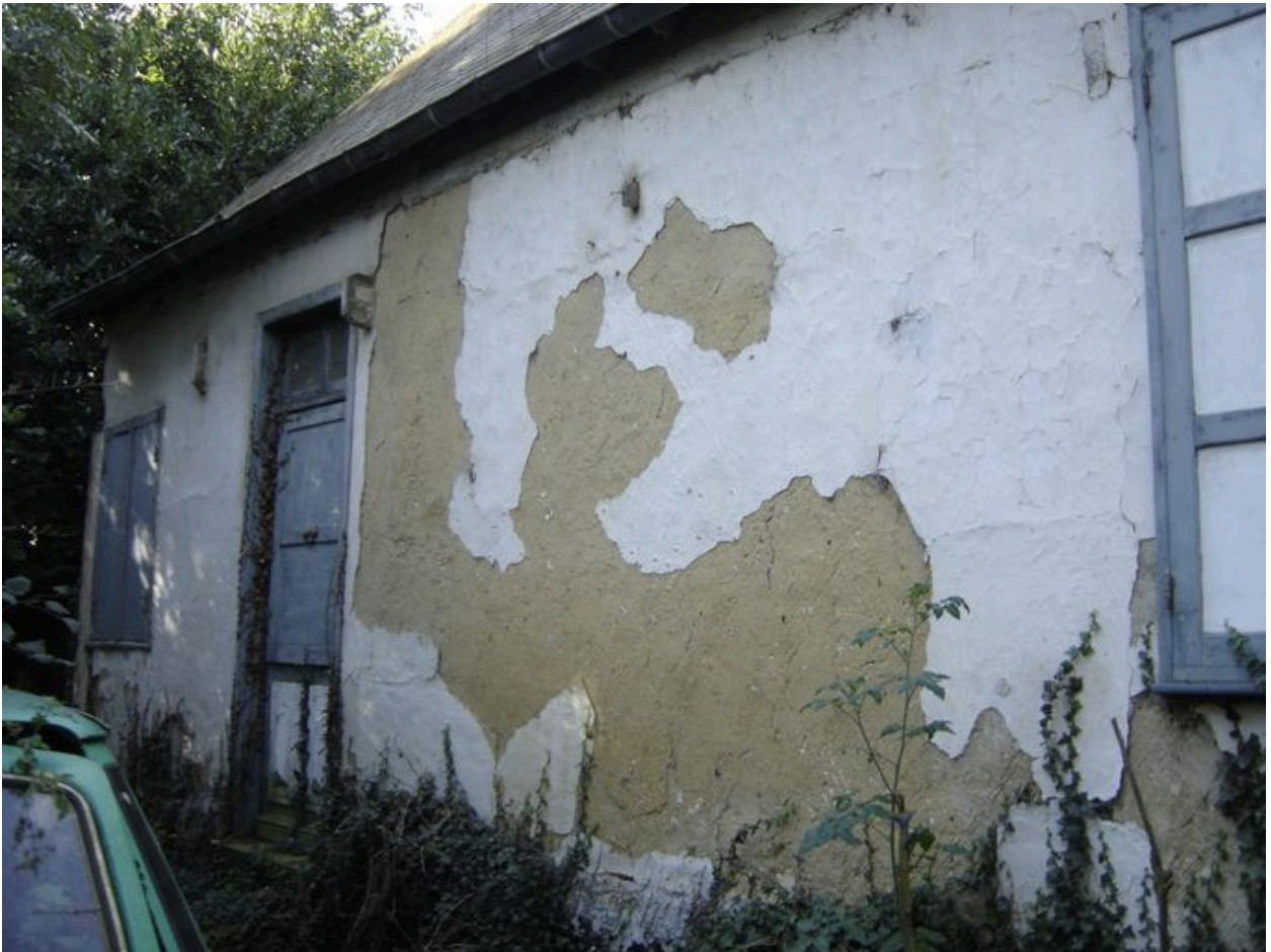
Détail des deux dernières travées.
