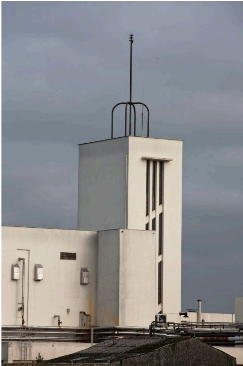
Détail de la tour d'escalier de l'atelier de fabrication (H), vers le nord-est.
