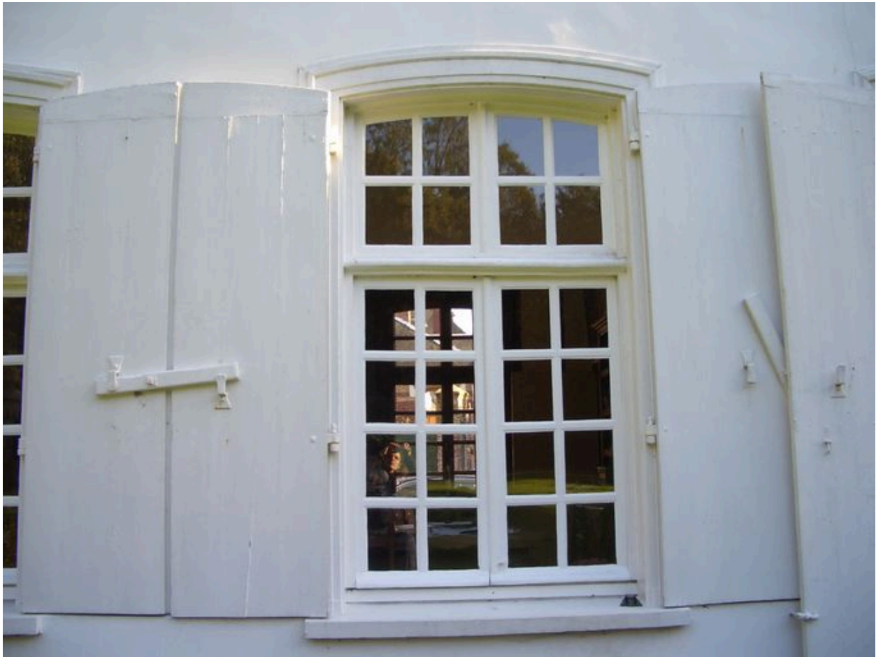
Vue détaillée des contrevents.
