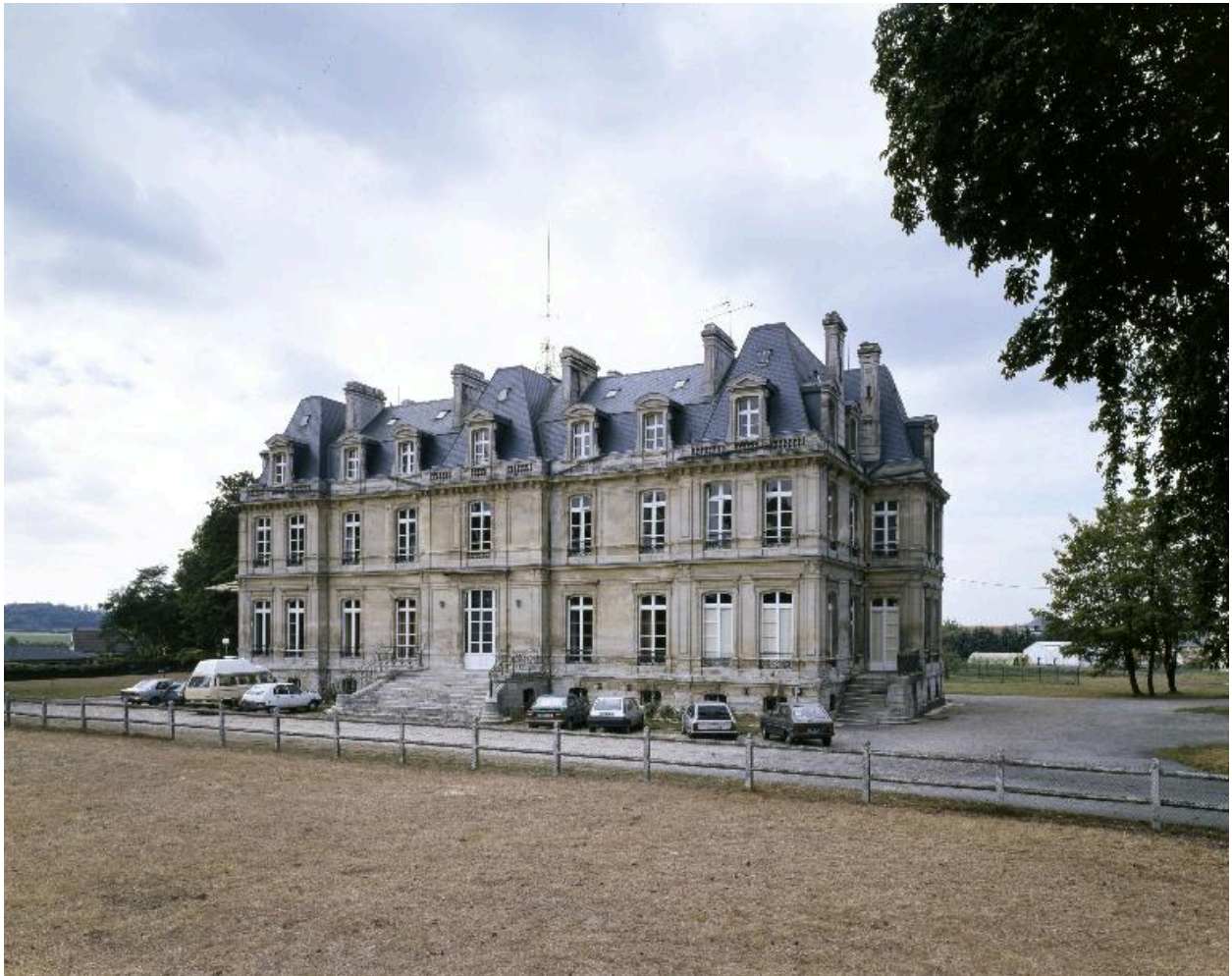
Vue de la façade orientale.
