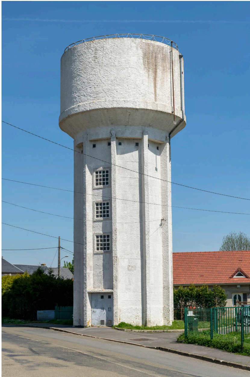
Château d'eau, rue de la Grand Cour.
