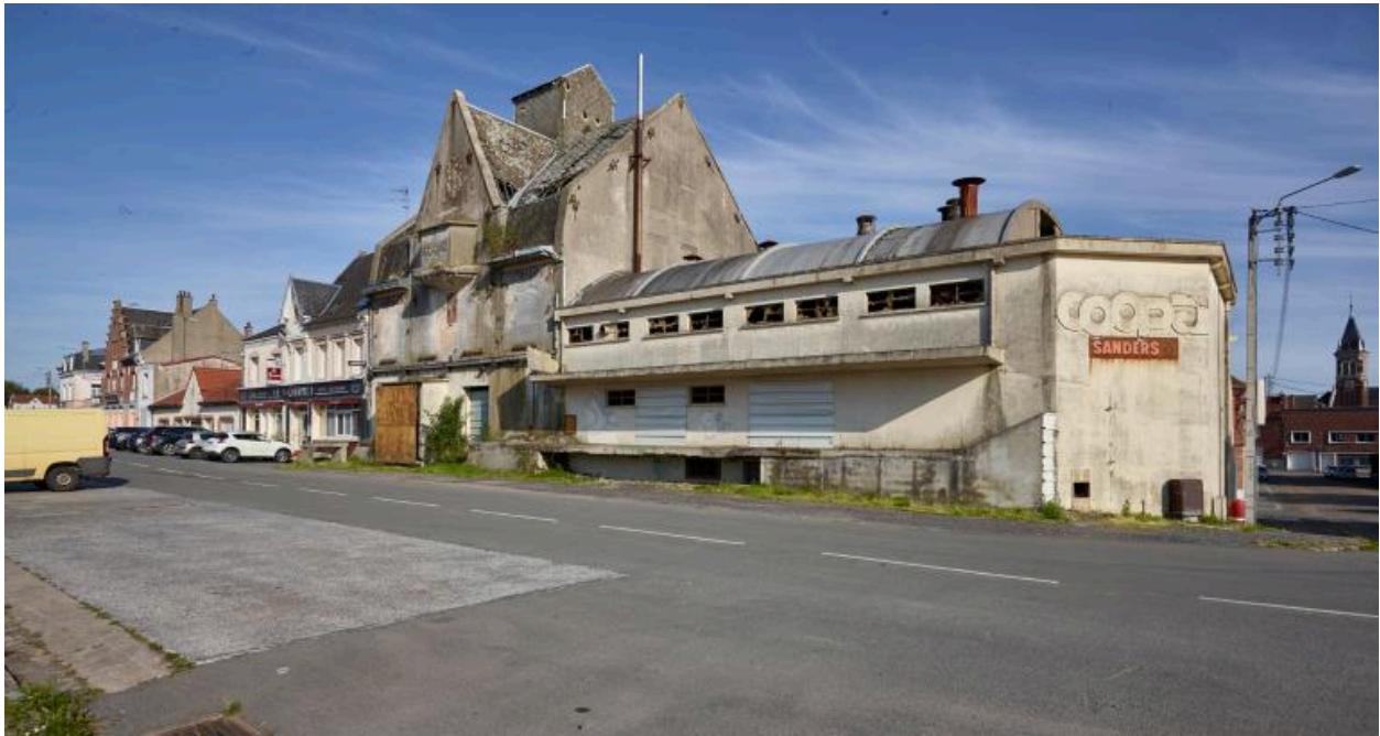
Vue générale côté sud.
