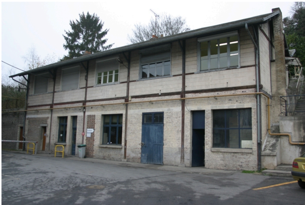
Façade sur cour des bureaux.
