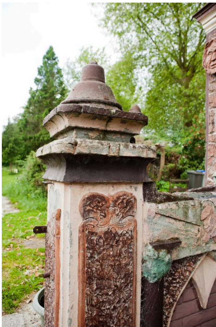
Détail de piliers d'arcade.
