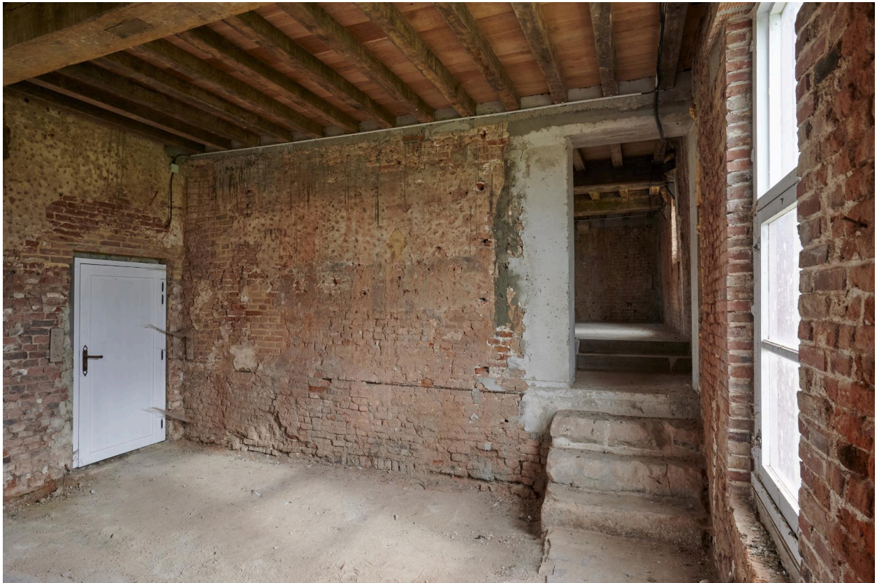
Rez-de-chaussée. Logis du XVIIe siècle. Cuisine et escalier menant à l'arrière-cuisine.
