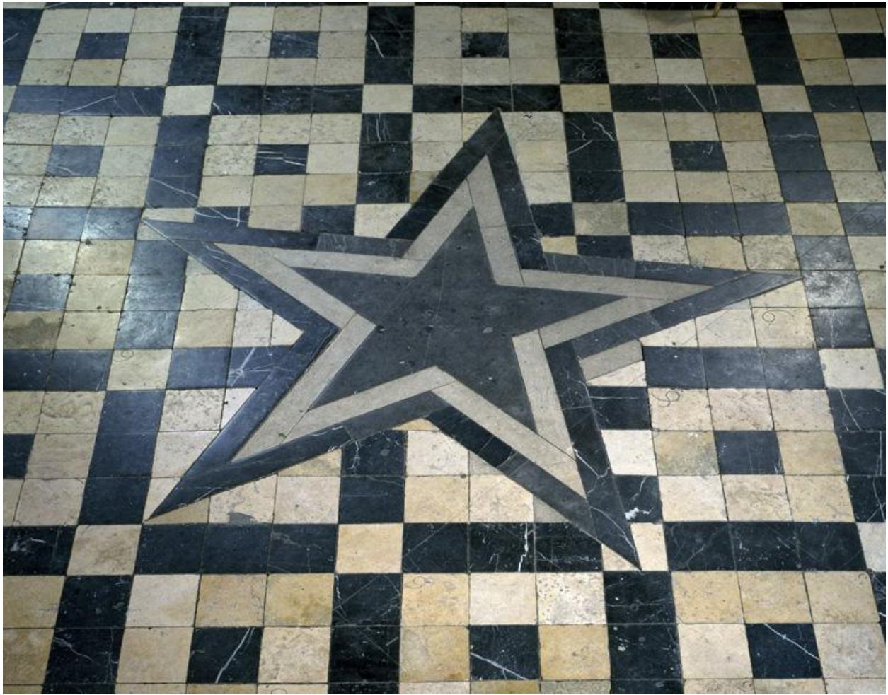
Détail de la partie centrale du pavement de la nef.
