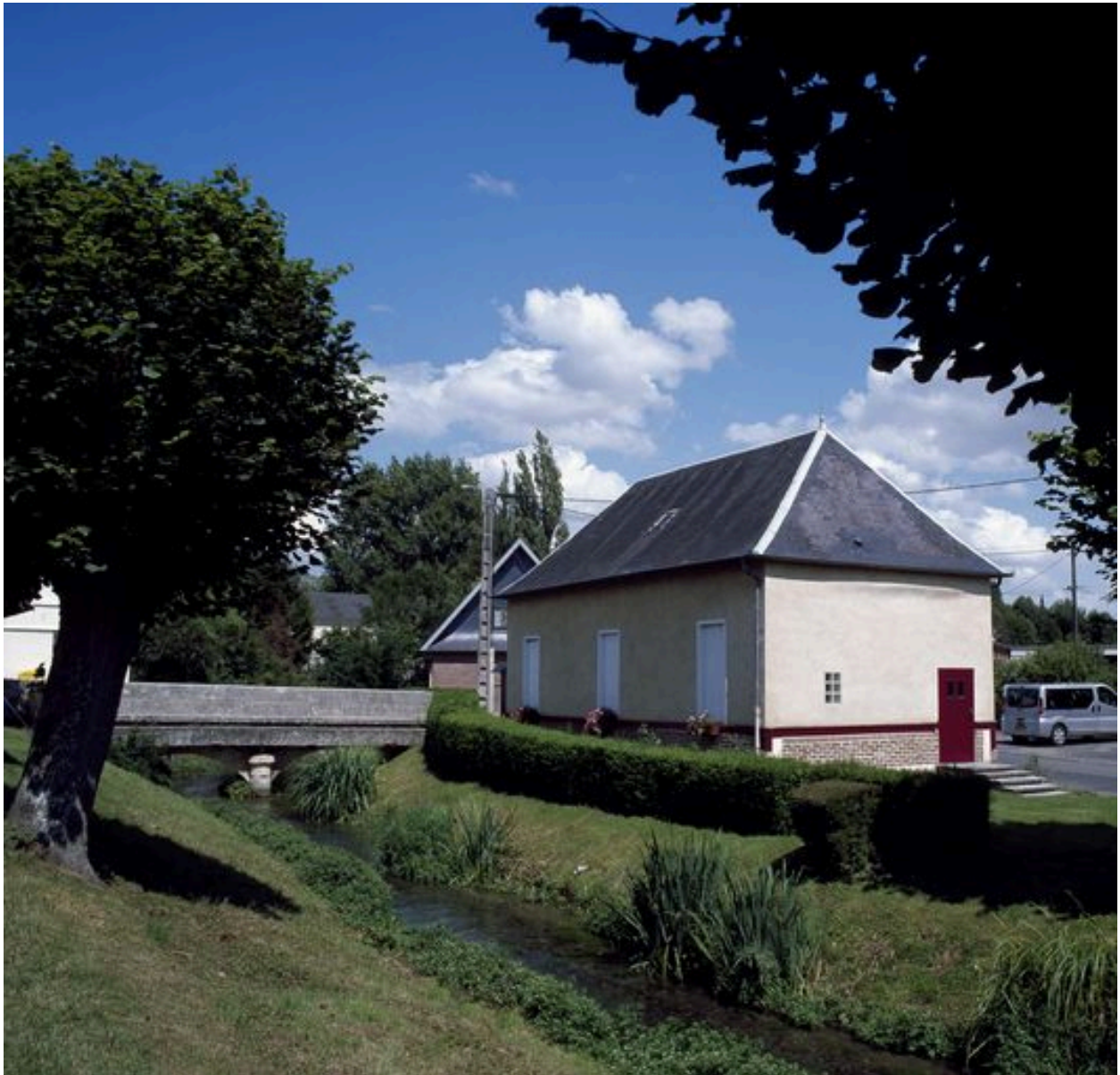
Vue générale depuis la Fieffes.
