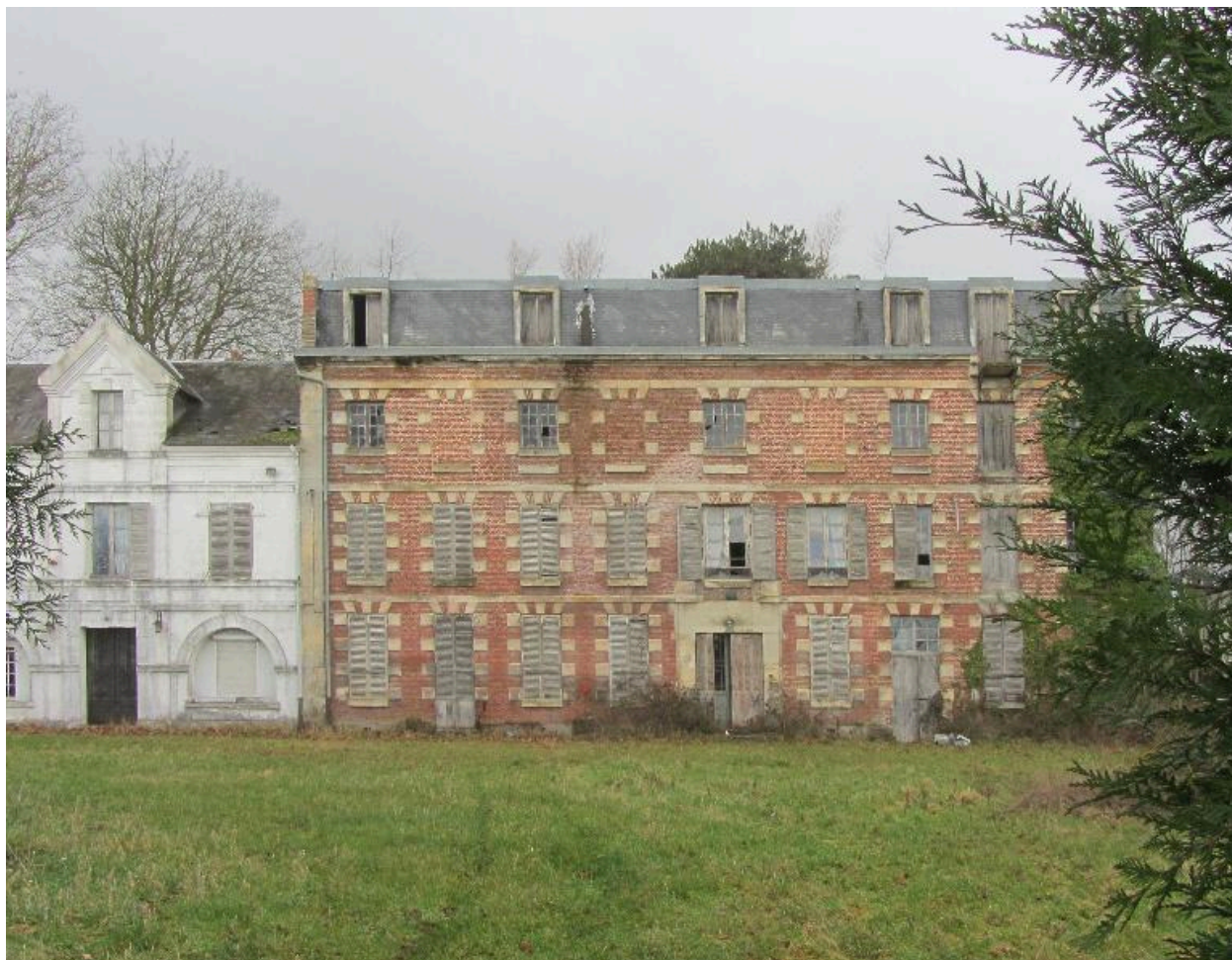
Ancien logement patronal de l'usine Lefrant.
