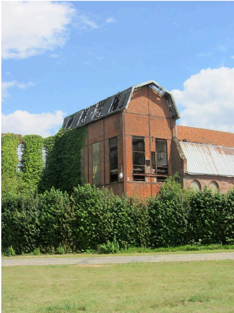
Vue partielle de la râperie, depuis le sud-ouest.
