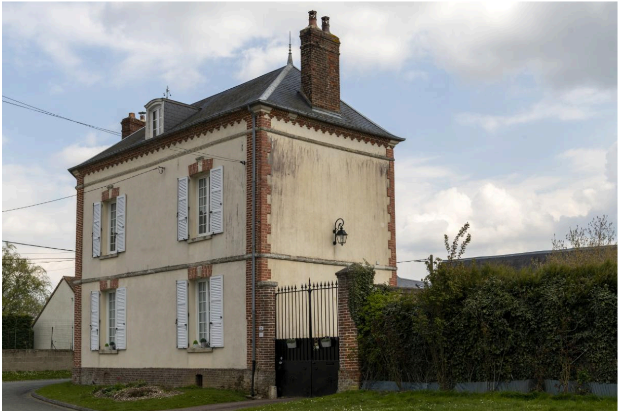
Logis de ferme, n°2 Impasse des Vignes, vue depuis l'ouest.
