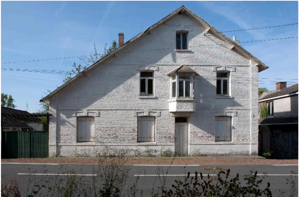
Maison 8 rue du Buridon.
