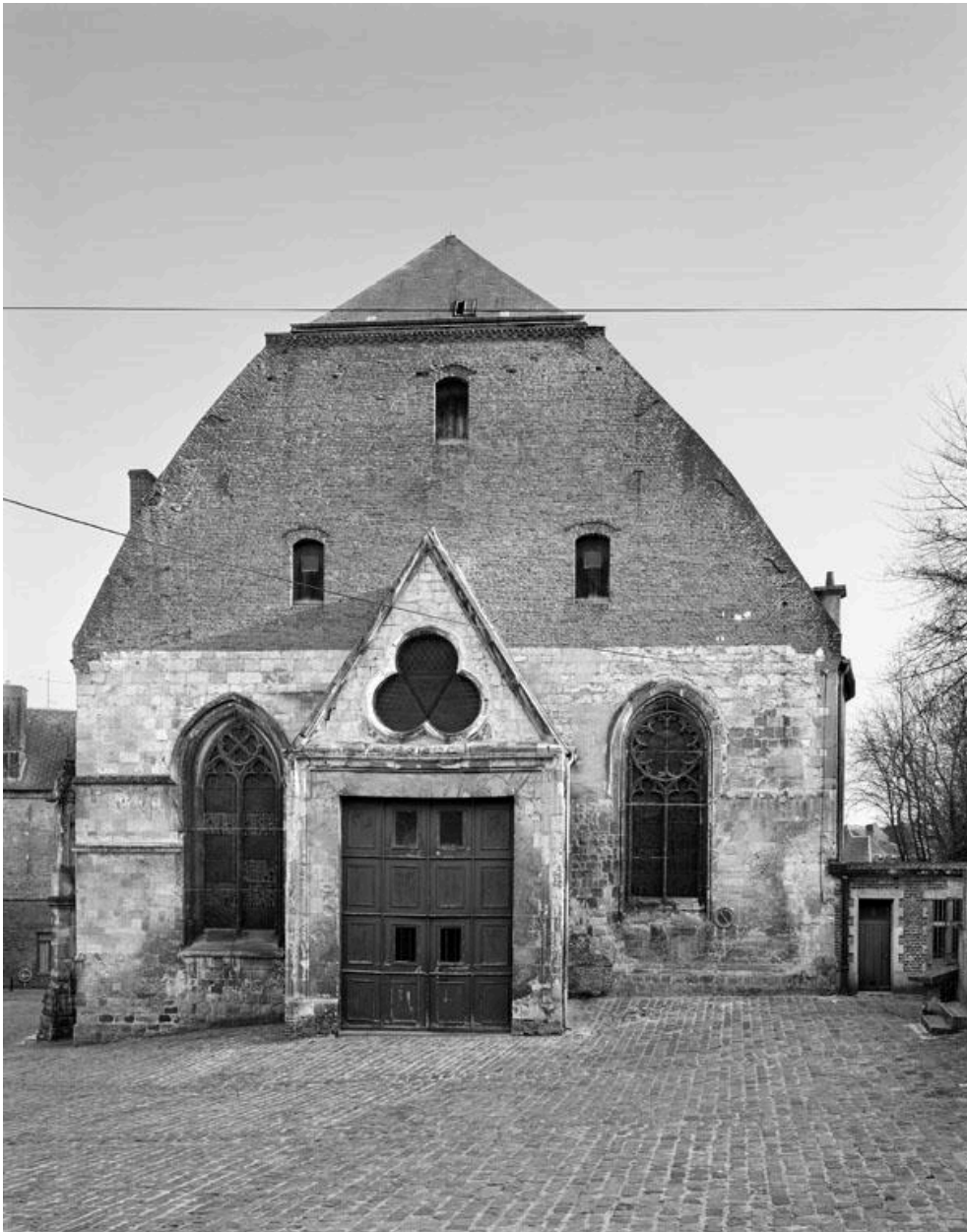
Vue de la façade occidentale.
