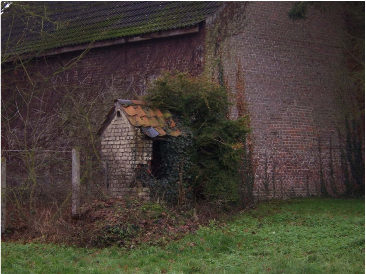
Vue générale du puits I.
