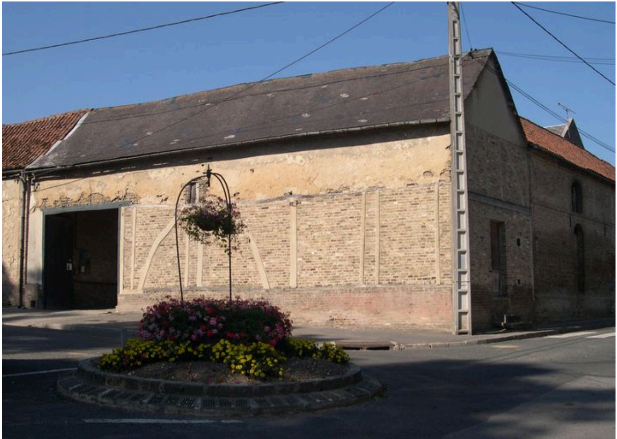
Le puits aménagé au croisement de la rue Paul-Cornet et de la rue des Bois.
