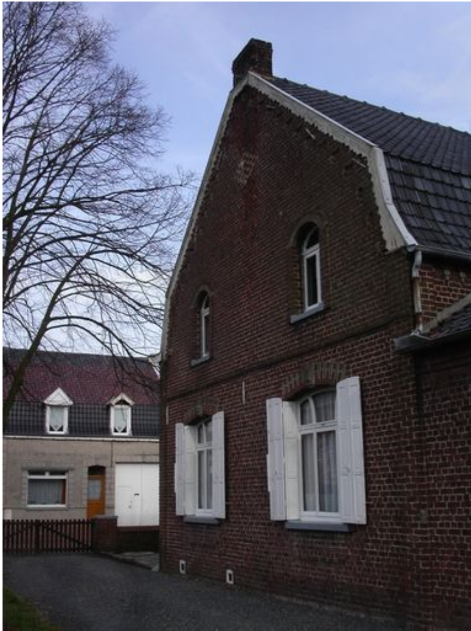
Vue du pignon de trois quarts depuis l'allée privée.
