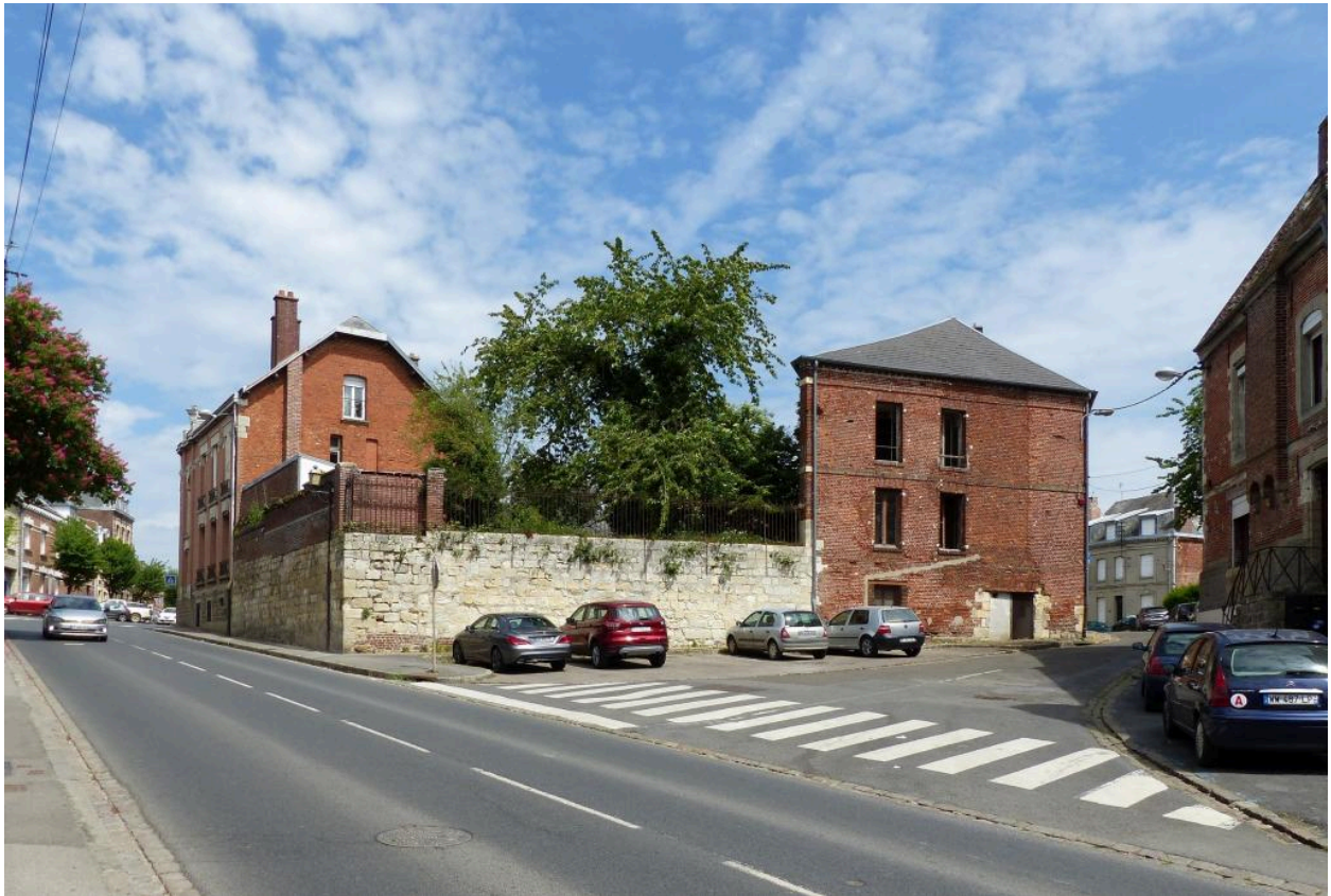
Vue de situation depuis la rue Saint-Fursy, en contrebas.
