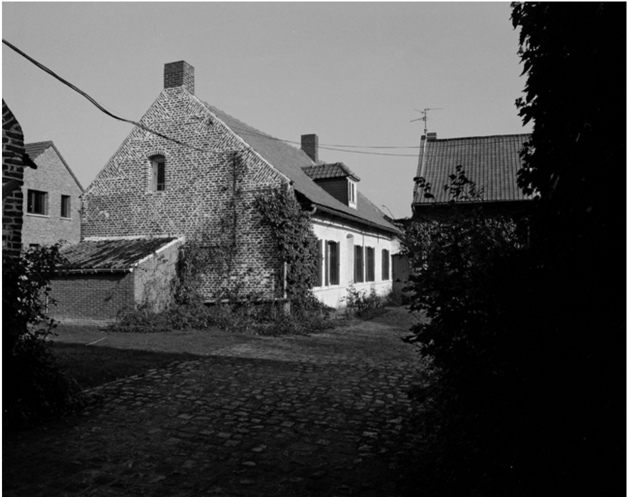
Ferme située très en retrait de la rue (dispositif du 17e siècle ?), rue Lelier.
