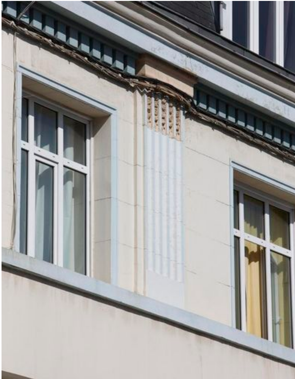
Détail d'un pilastre témoignant d'une réinterprétation moderne du style classique.
