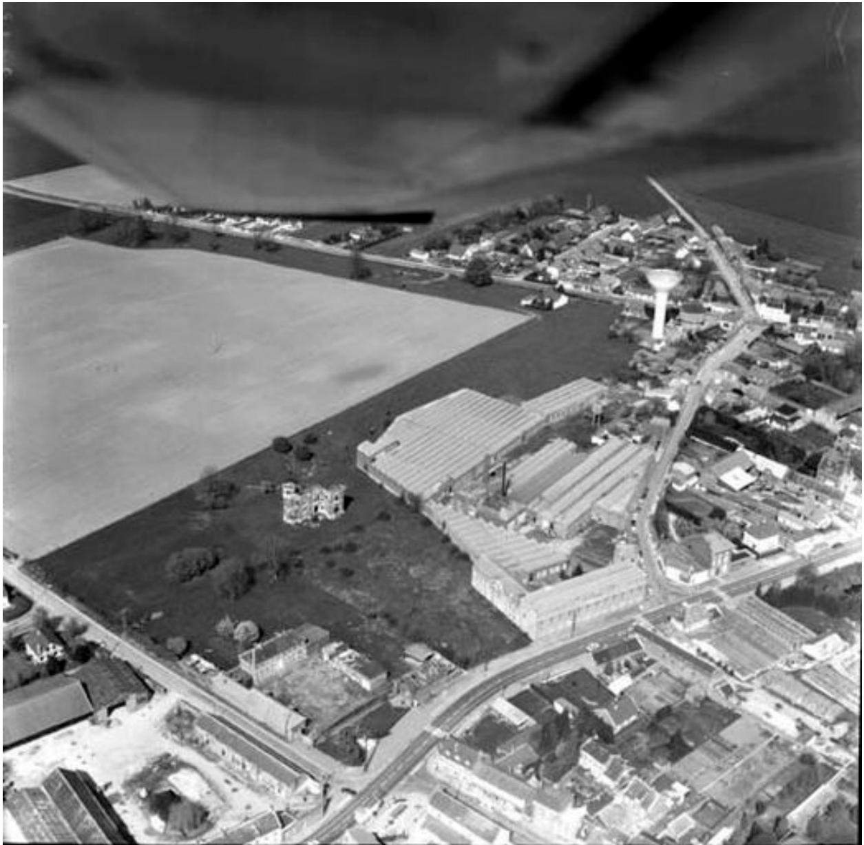
Vue aérienne, flanc sud-ouest.
