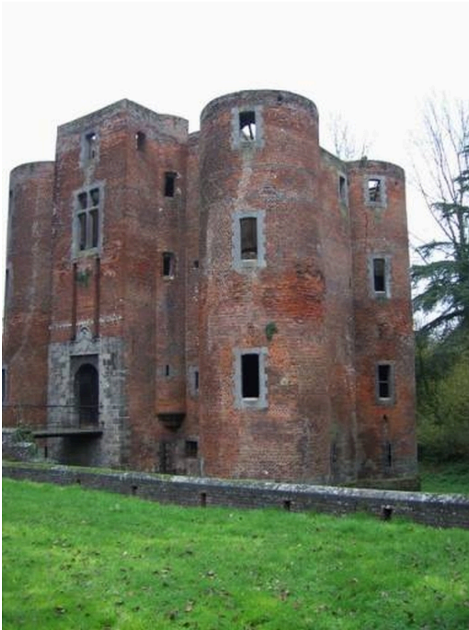
Vue générale, façades sud et est.
