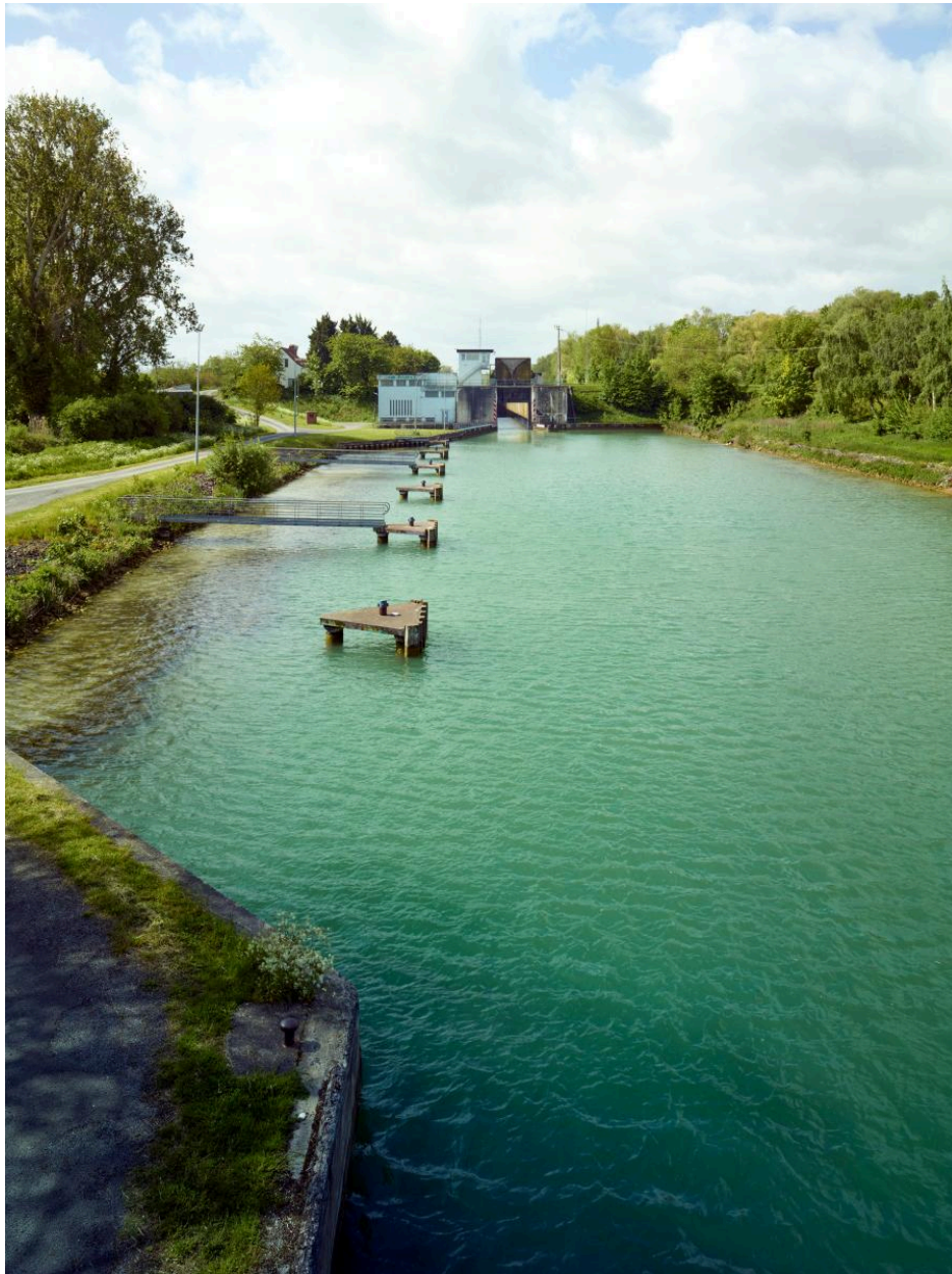
Vue générale prise depuis le pont routier, en aval du site.
