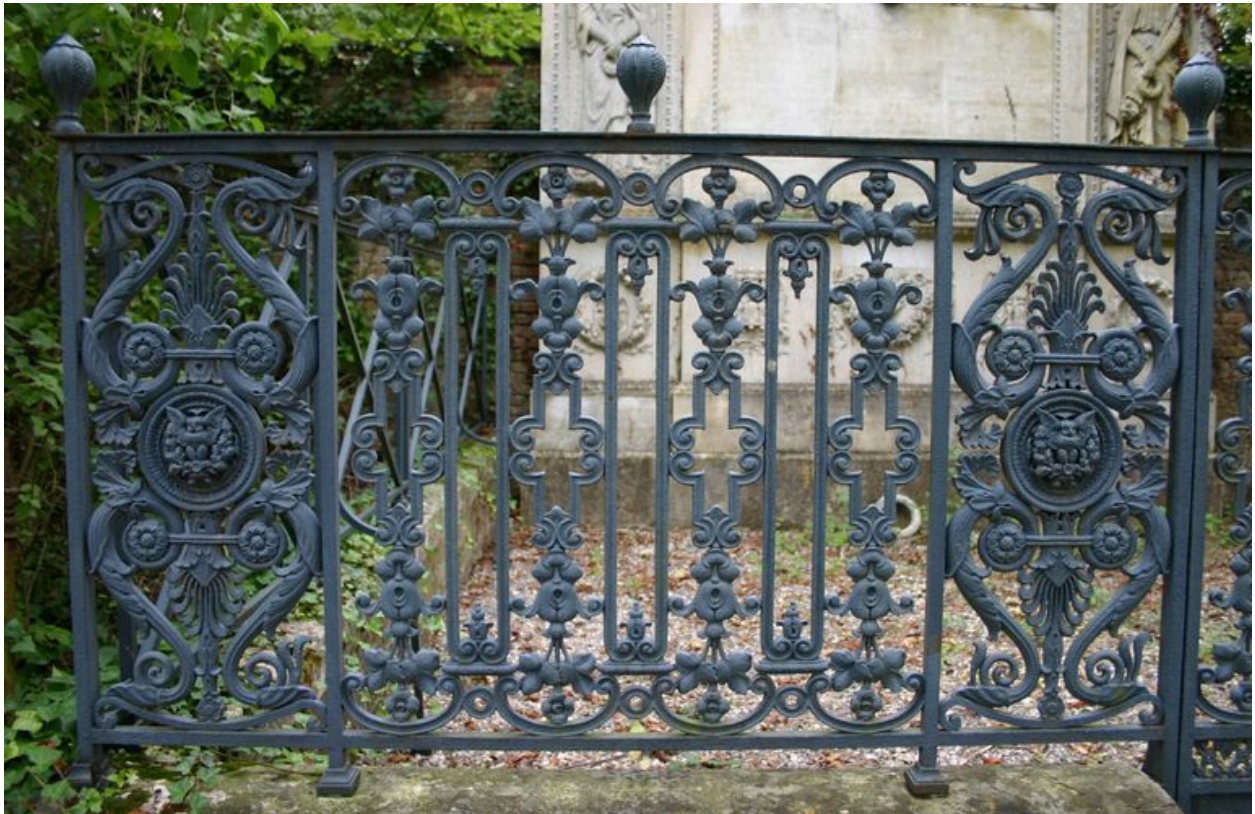
Elément de la grille de clôture ouvragée.
