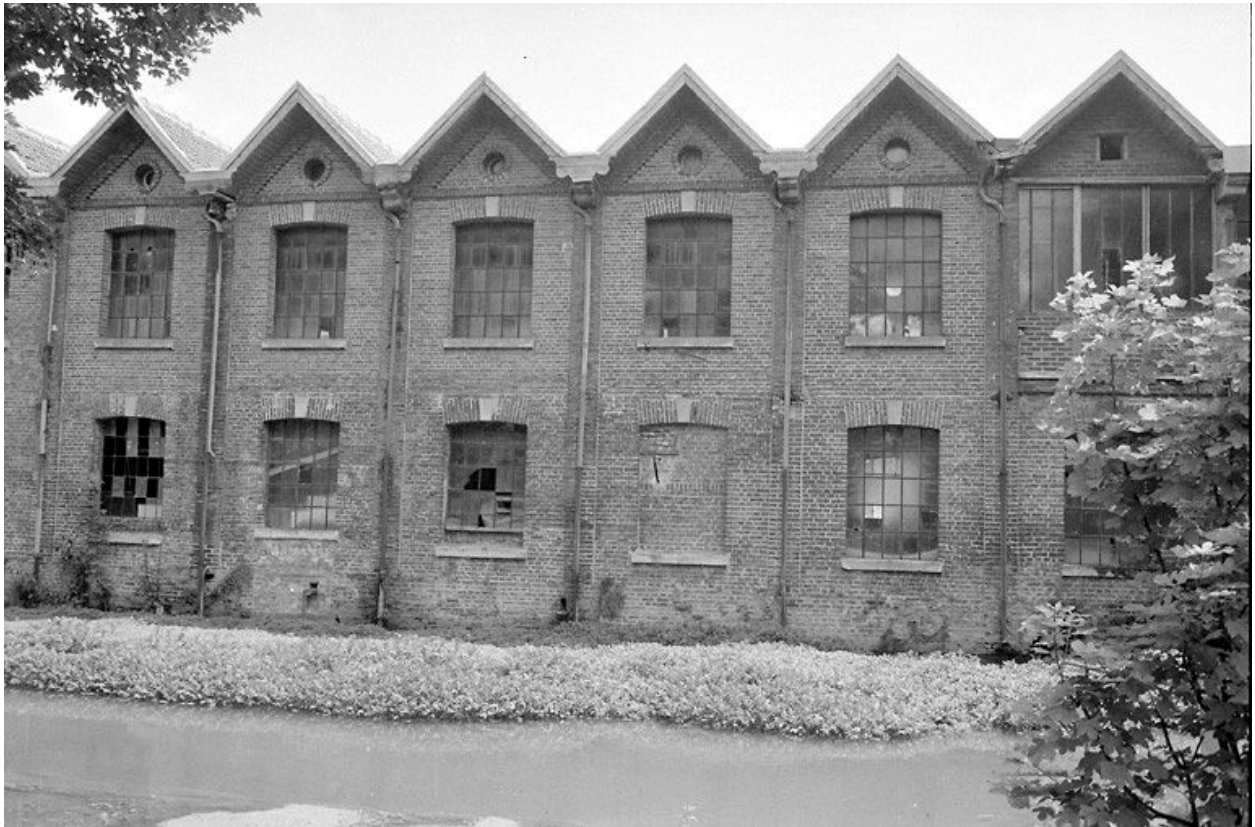
Ateliers de fabrication, flanc ouest, vue partielle.
