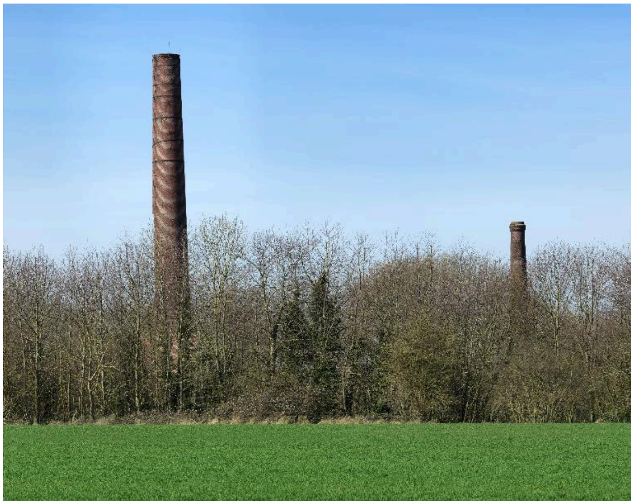
Cheminée de l'usine en ruine.
