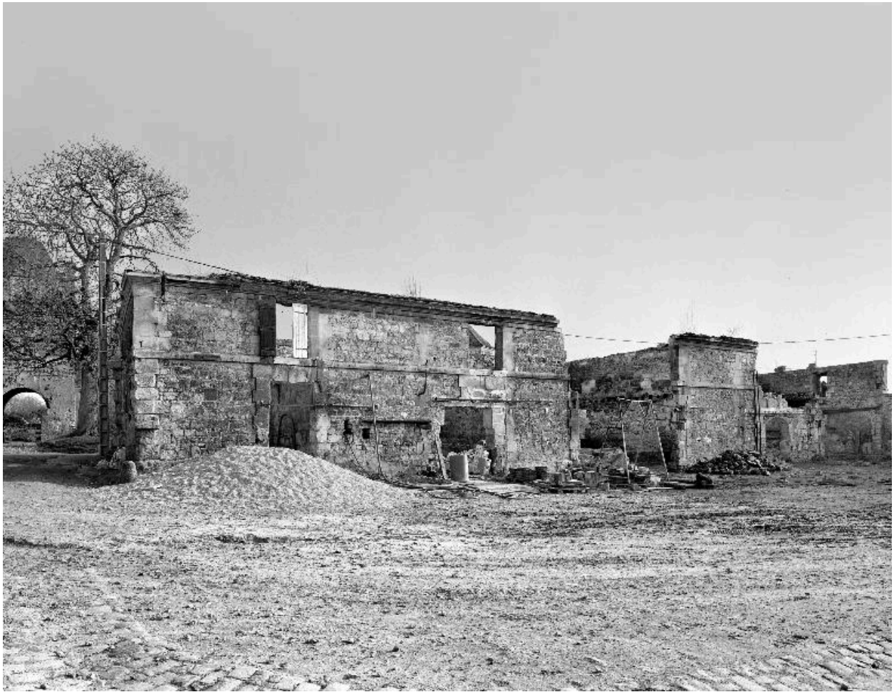
Élévation sur cour des étables sud-ouest (après un incendie).
