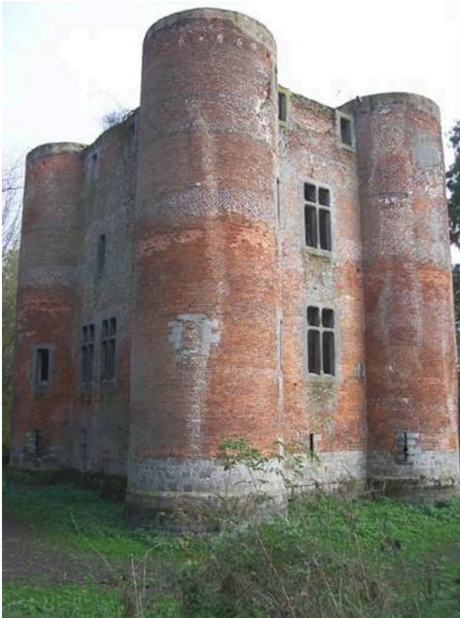
Vue générale des élévations nord et ouest.
