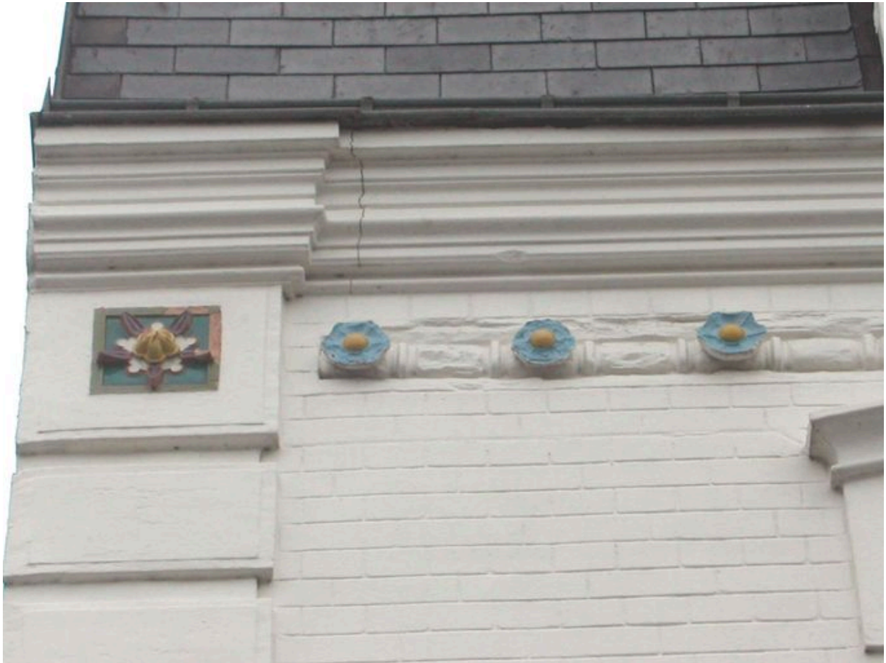
Détail des rosaces en céramique sur le faîte du mur gouttereau.
