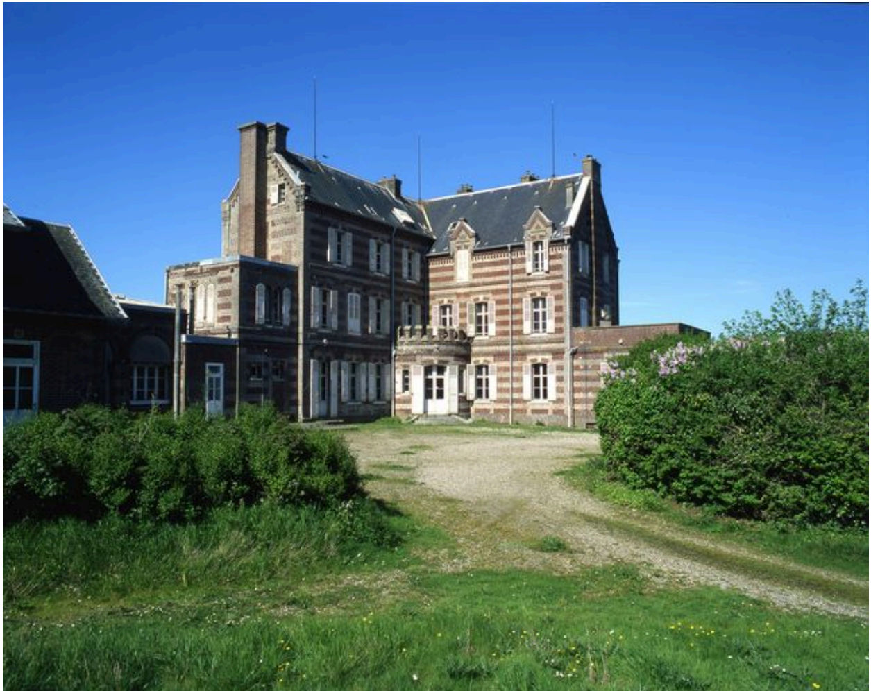
Vue d'ensemble du corps de logis principal, angle est.
