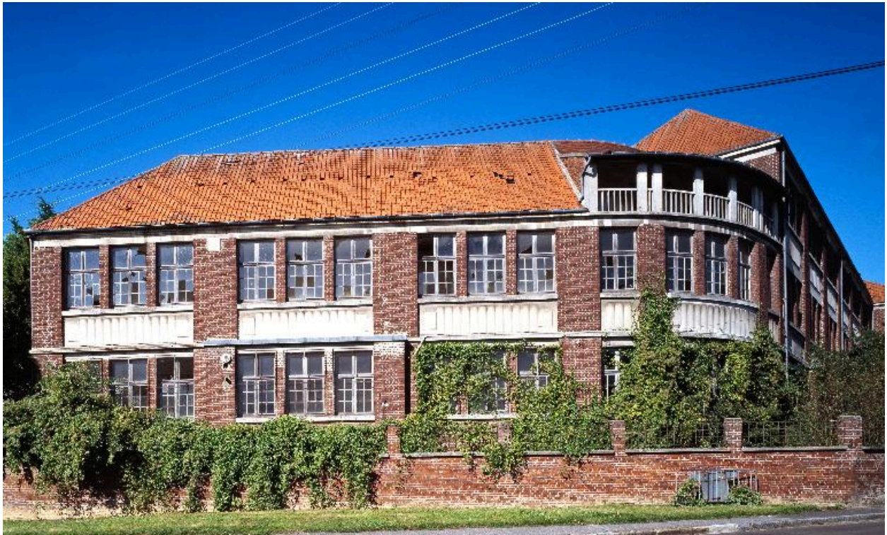
Façade à l'angle des rues Delzaize et Auguste Dehaussy.
