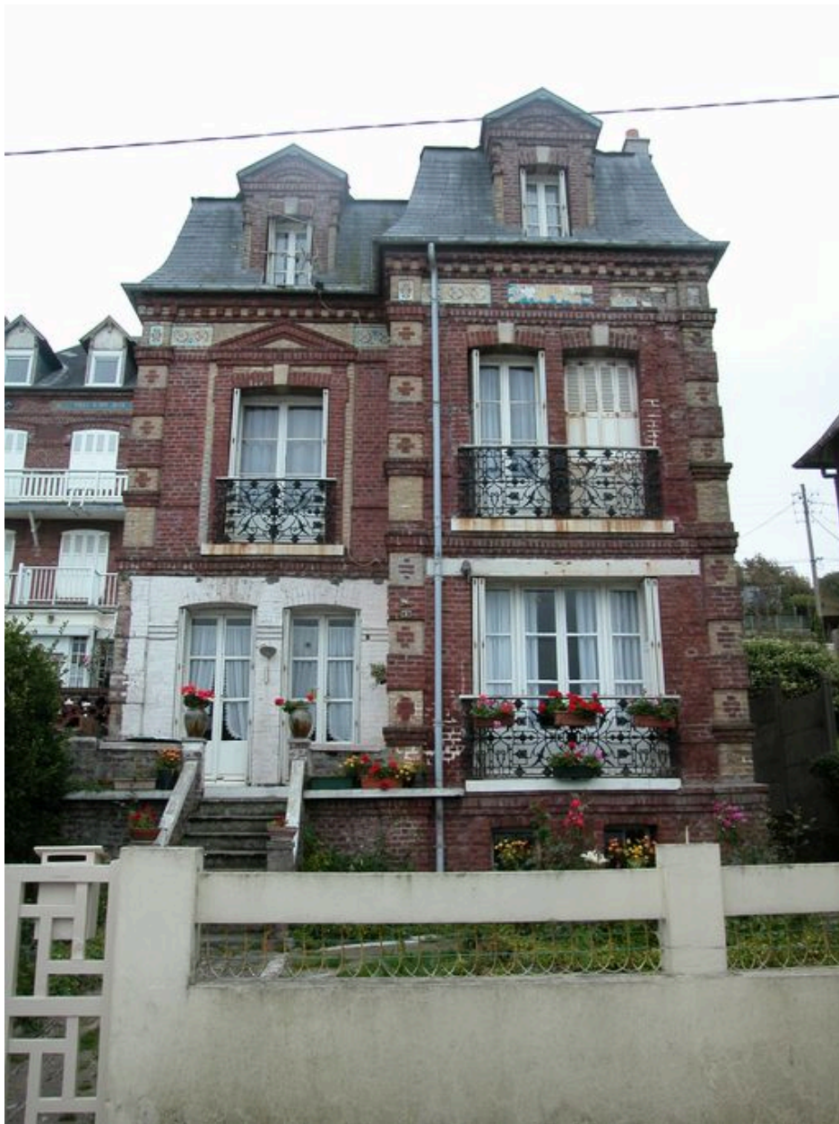
Vue d'ensemble de l'élévation côté mer.
