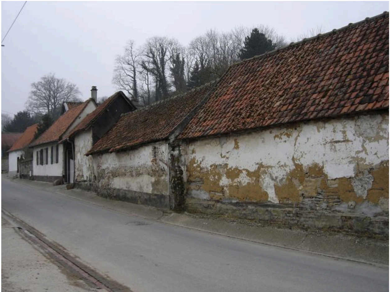
Vue des bâtiments agricoles sur rue.
