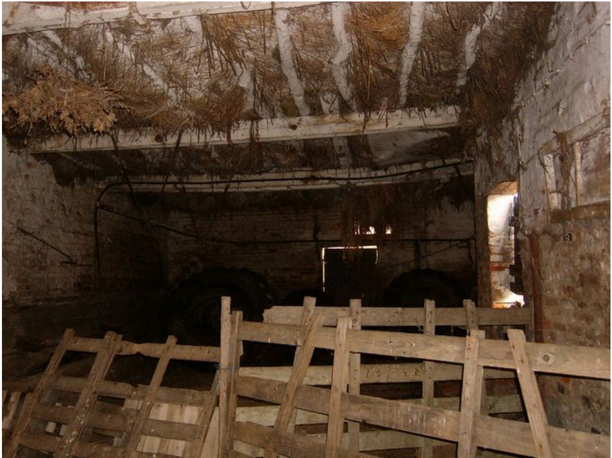
Vue intérieure des étables.
