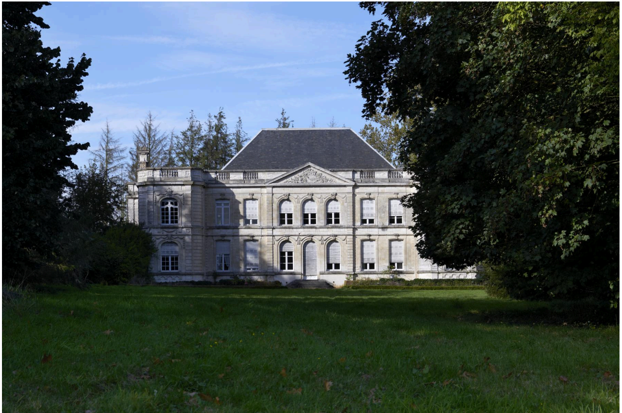
Vue générale de l'élévation côté parc prise depuis la rue d'Aire.
