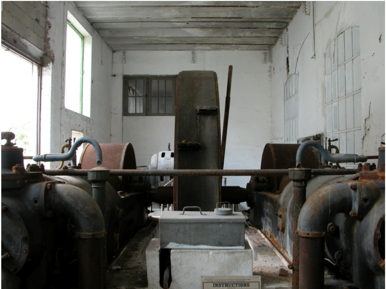
Vue générale de la machine à gaz.
