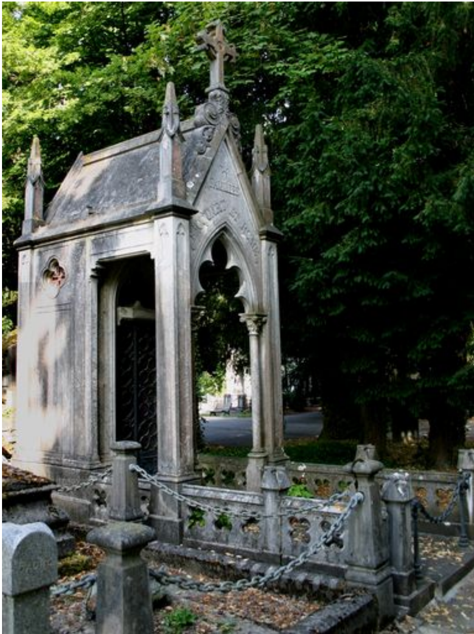
Façade latérale du tombeau-chapelle.
