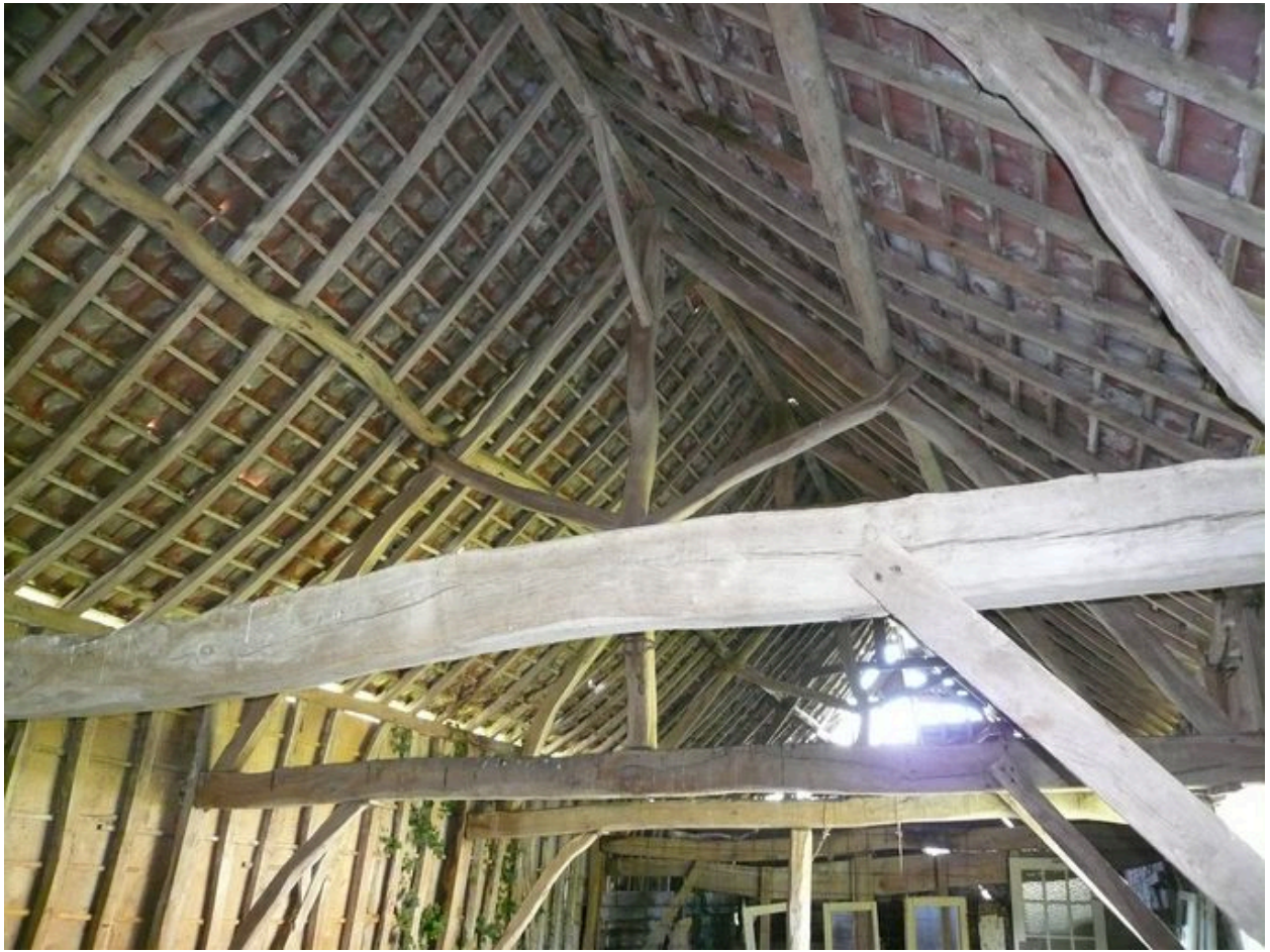
Vue de la charpente.
