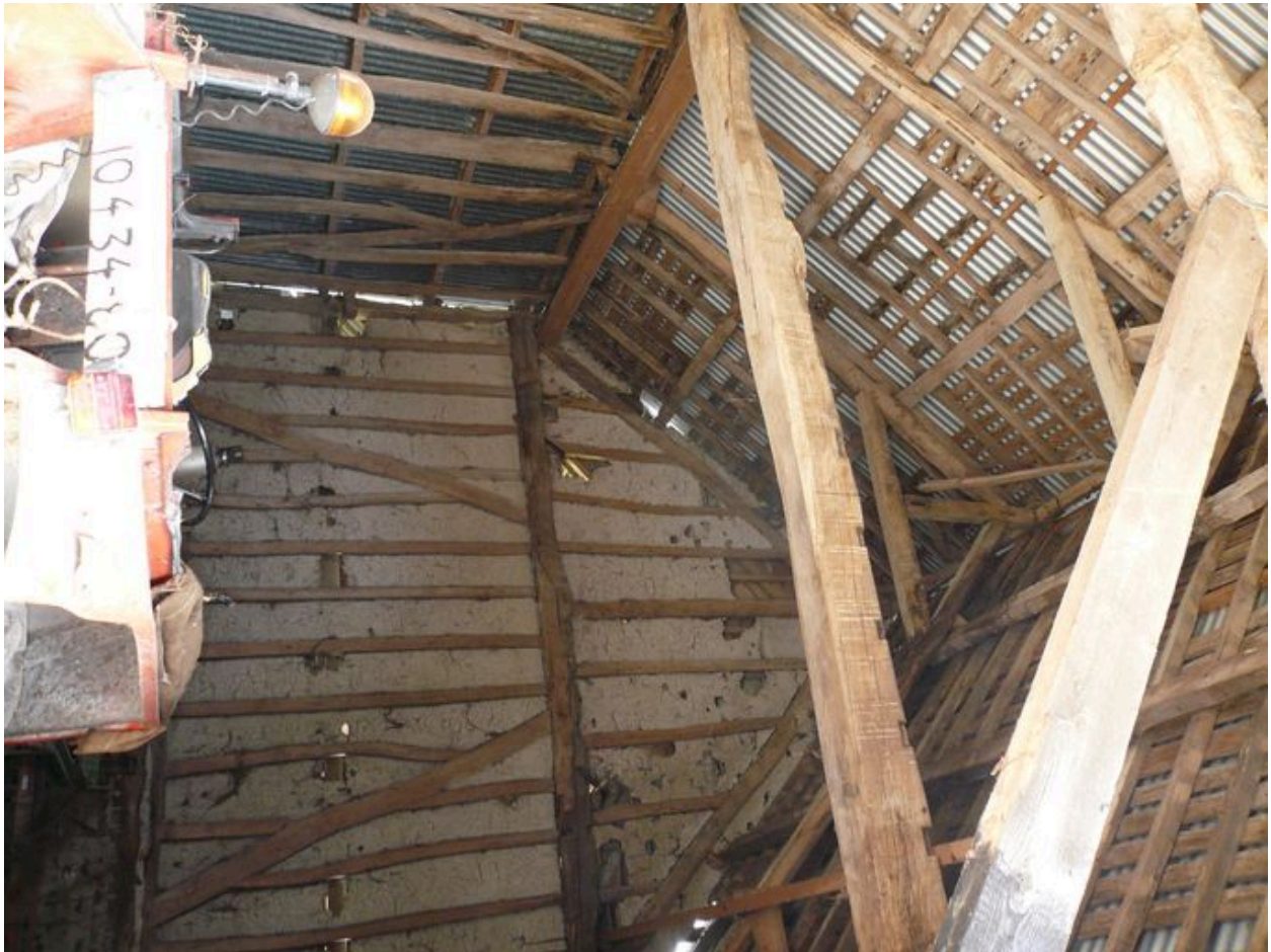
Vue intérieure de la grange.
