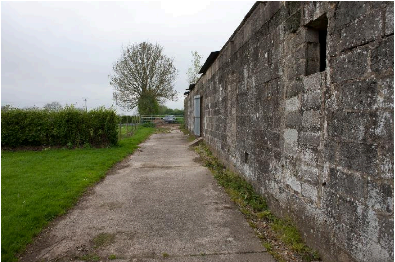
Bâtiment de stockage d'attente. Détail de l'élévation.
