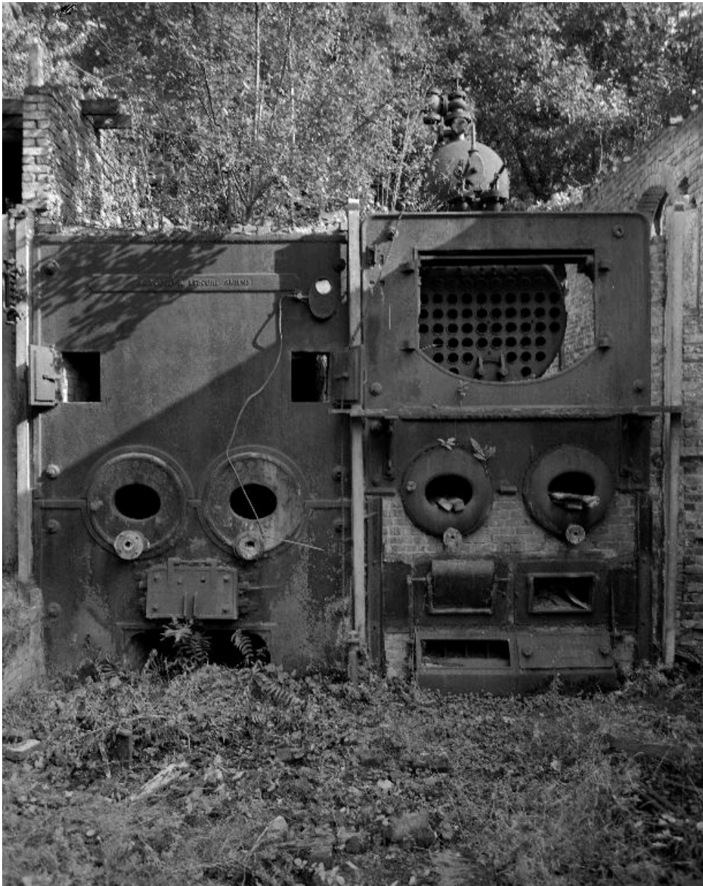
Chaufferie, chaudières à vapeur (constructeur : Veillet et Lescure Amiens et Louis Fontaine).
