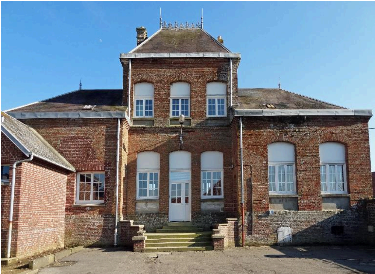
Vue générale de l'élévation postérieure
